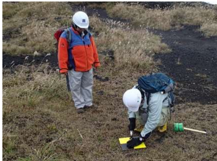
図 6 対空標識の設置状況
